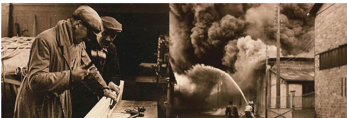
1960 : les débuts à La Rochelle Incendie de l'Ateliers ARPIN le 3 février 1968 (Sur le site AMEL)
